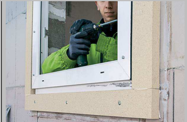
Obr._08: Příklad použití purenitů výroby puren, tedy funkčního izolačního materiálu podobného materiálům na bázi dřeva, tentokrát jako okenního rámu. Fotka: puren
