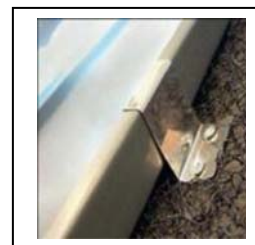
Obr.5 Příponka plechu na strukturované rohoži
