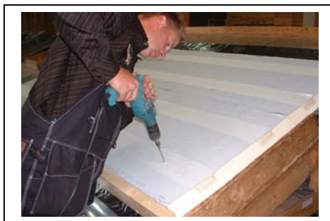
Obr.6 kotvení desek PIR do krokví
